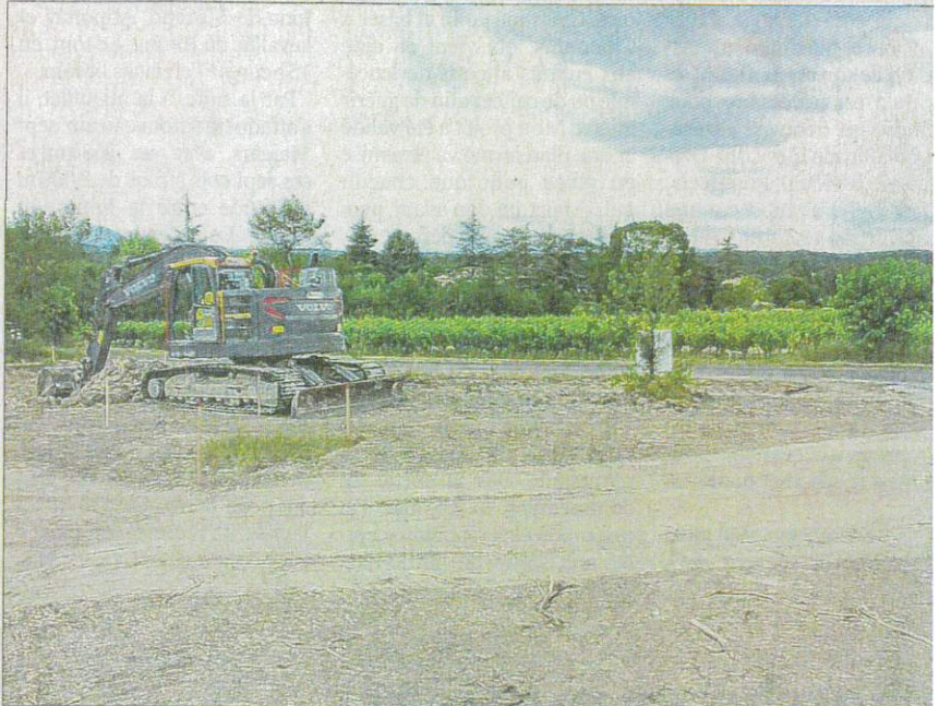
Malgré l'opposition, les travaux ont déjà commencé à l'emplacement du lotissement du Clos de Baron.
